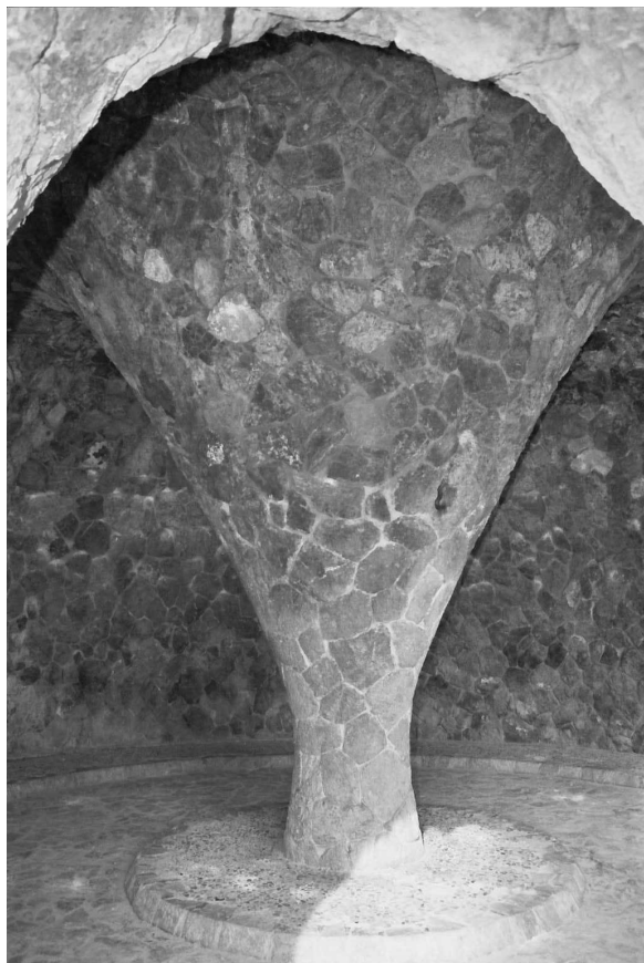
Fig. 5.28 Volta hiperbòlica per al gir de carruatges al Parc Güell
